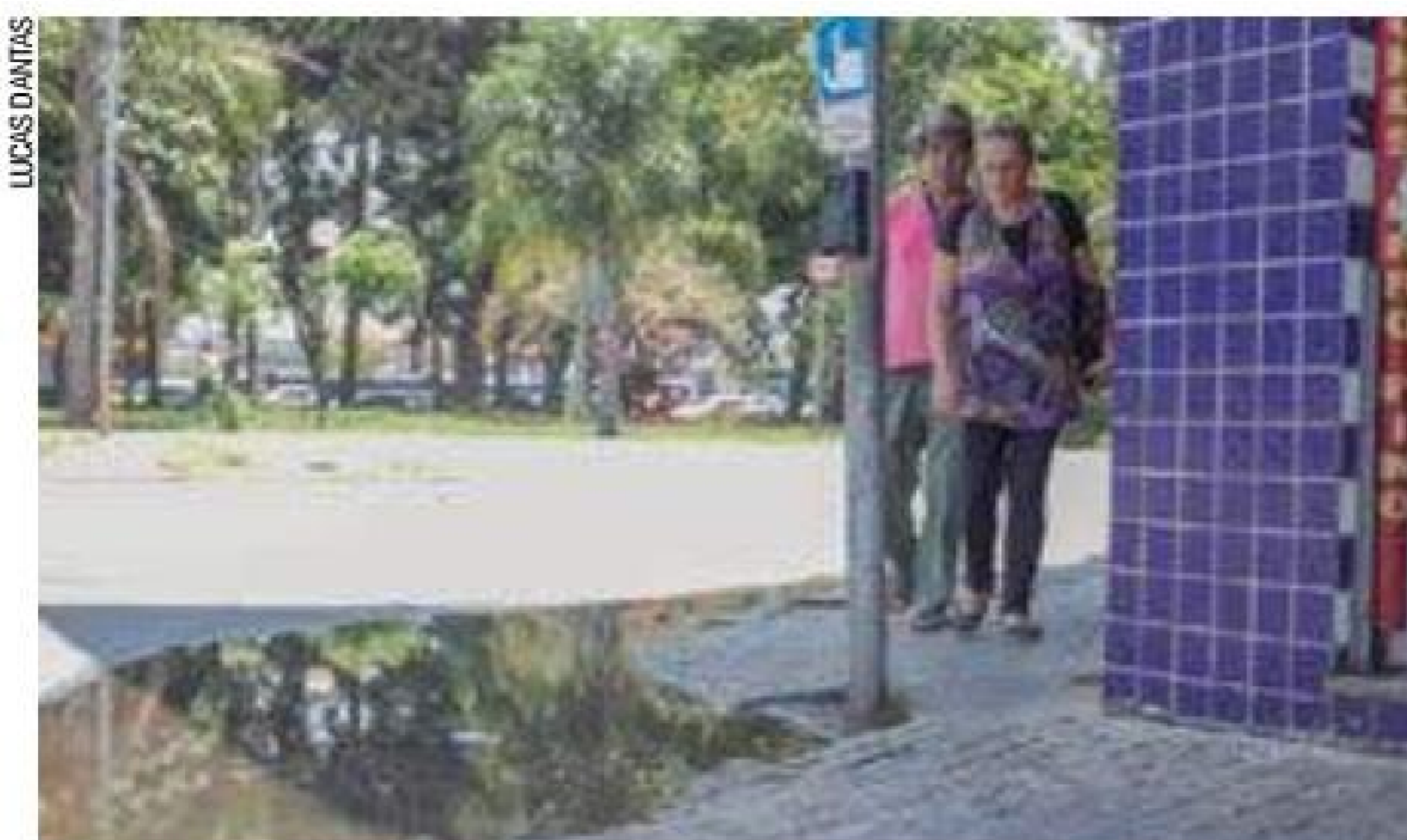
Desvio - Esgoto faz transeuntes terem acesso pequeno para passar
