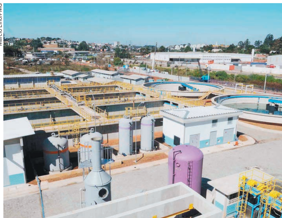
Estação de Tratamento de Esgoto (ETE) de Bonsucesso, que atenderia 260 mil pessoas
