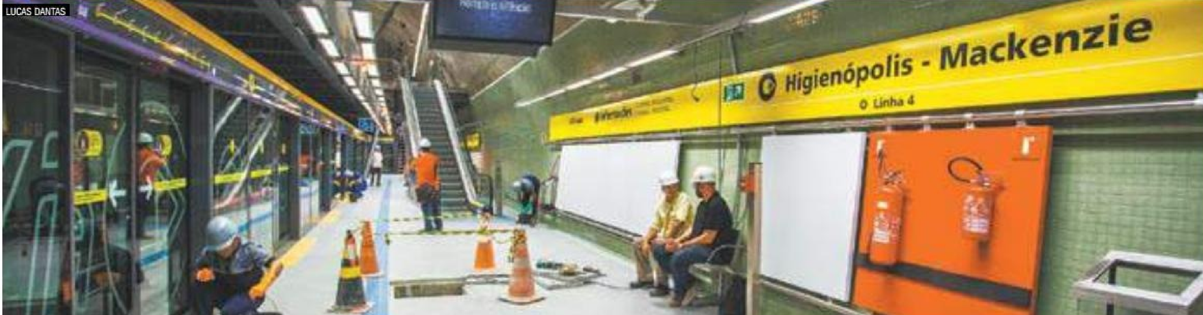
Retoques - Operários fizeram, ontem, na estação Higienópolis/Mackenzie, da Linha 4-Amarela, os ajustes finais antes da inauguração; serviço será parcial até 3 de fevereiro
